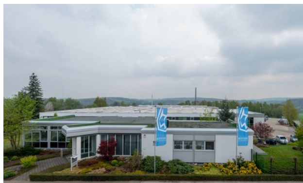
Gebäude von Hoven Hydraulik, Foto: Internet
